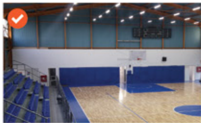
Ανακαίνιση Κλειστού Γυμναστηρίου στο Άνω Καλαμάκι (νέο παρκέ, κερκίδες, αποδυτήρια κ.ά.)
