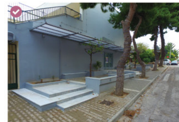
Ριζική ανακαίνιση του δημοτικού θεάτρου " Κάρολος Κουν " (σκηνή, φουαγιέ, δημιουργία παρασκηνίων, στέγαστρο, διαμόρφωση εξωτερικού χώρου, νέος εξοπλισμός ήχου και φωτισμού κ.ά.)
