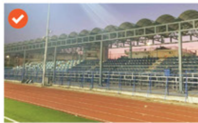
Νέο στέγαστρο στην κερκίδα θεατών στο γηπέδο Τραχώνων
