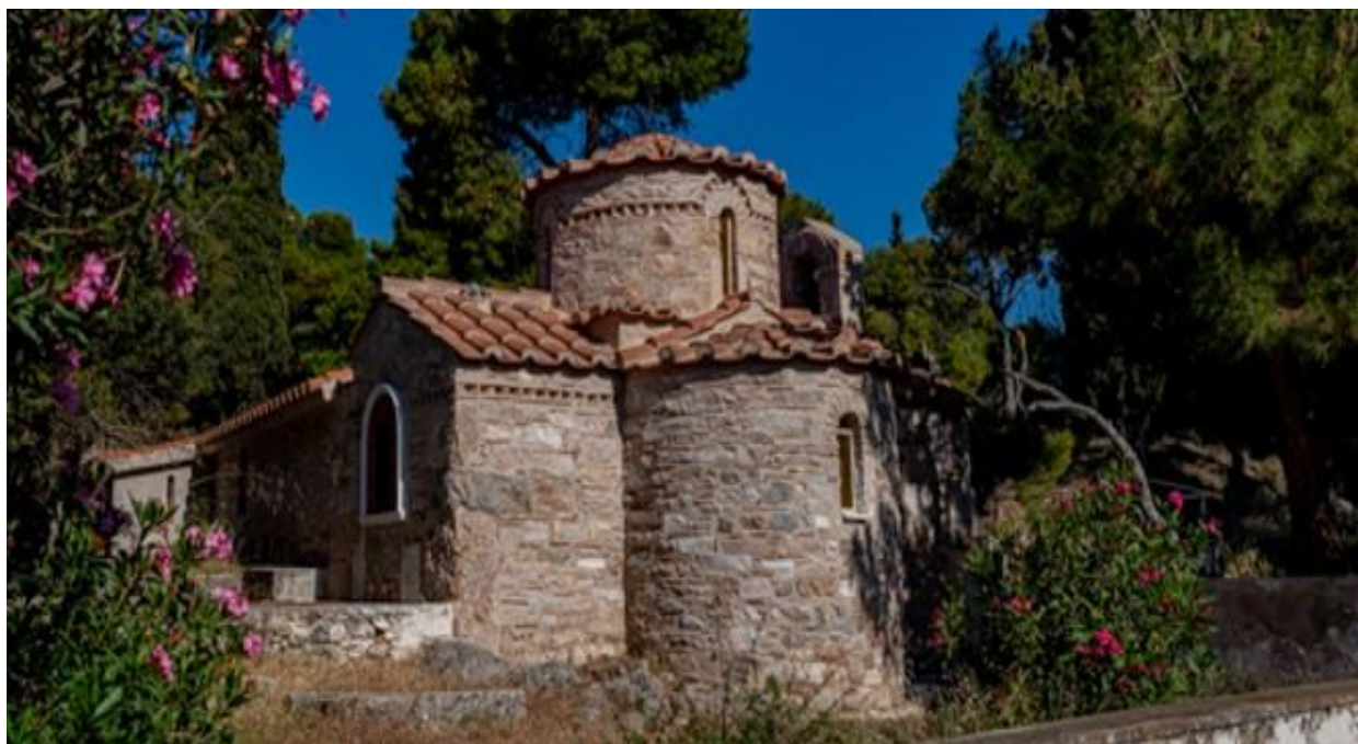
Εικόνα 16: Αποψη της Βυζαντινής εκκλησίας των Τραχώνων. Πηγή: Τζώτζος Γ. (6/6/2021)
